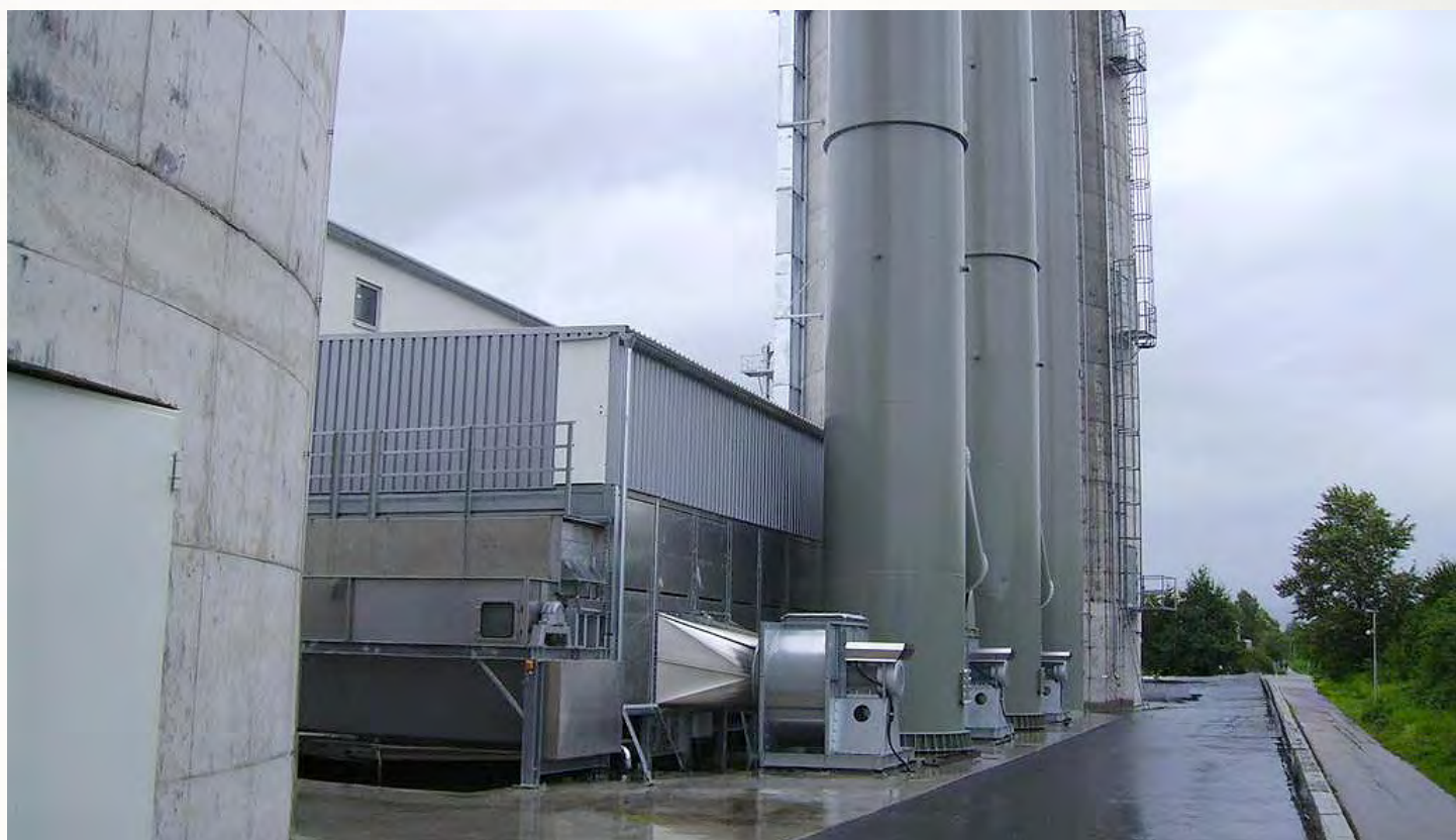
项目地: Dr. Gies Vermögensverwaltung - Future Energies GmbH, 德国 | 型号: BT 1/6200-22.5 | 安装年份: 2007 干燥物料: 木屑 | 出料能力: 约8.0吨/小时 | 降水区间: 48% - 8%湿度
