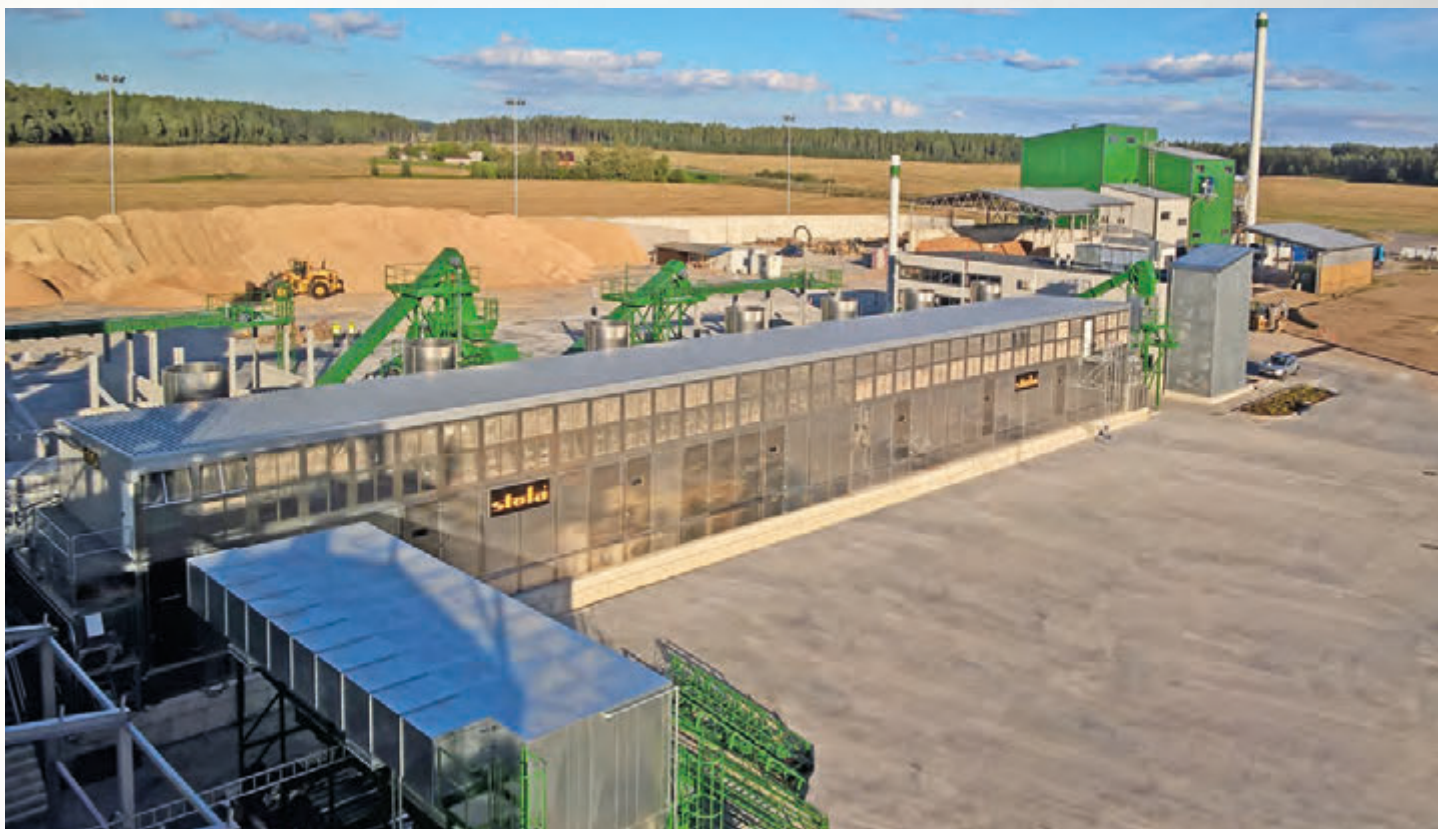
项目地：SIA „Pellet 4 Energia“ 拉脱维亚 | 型号：BT 1/6200-57 | 安装年份：2016 干燥物料：木屑 | 出料能力：约18.0吨/小时 | 降水区间：50% - 10%湿度
