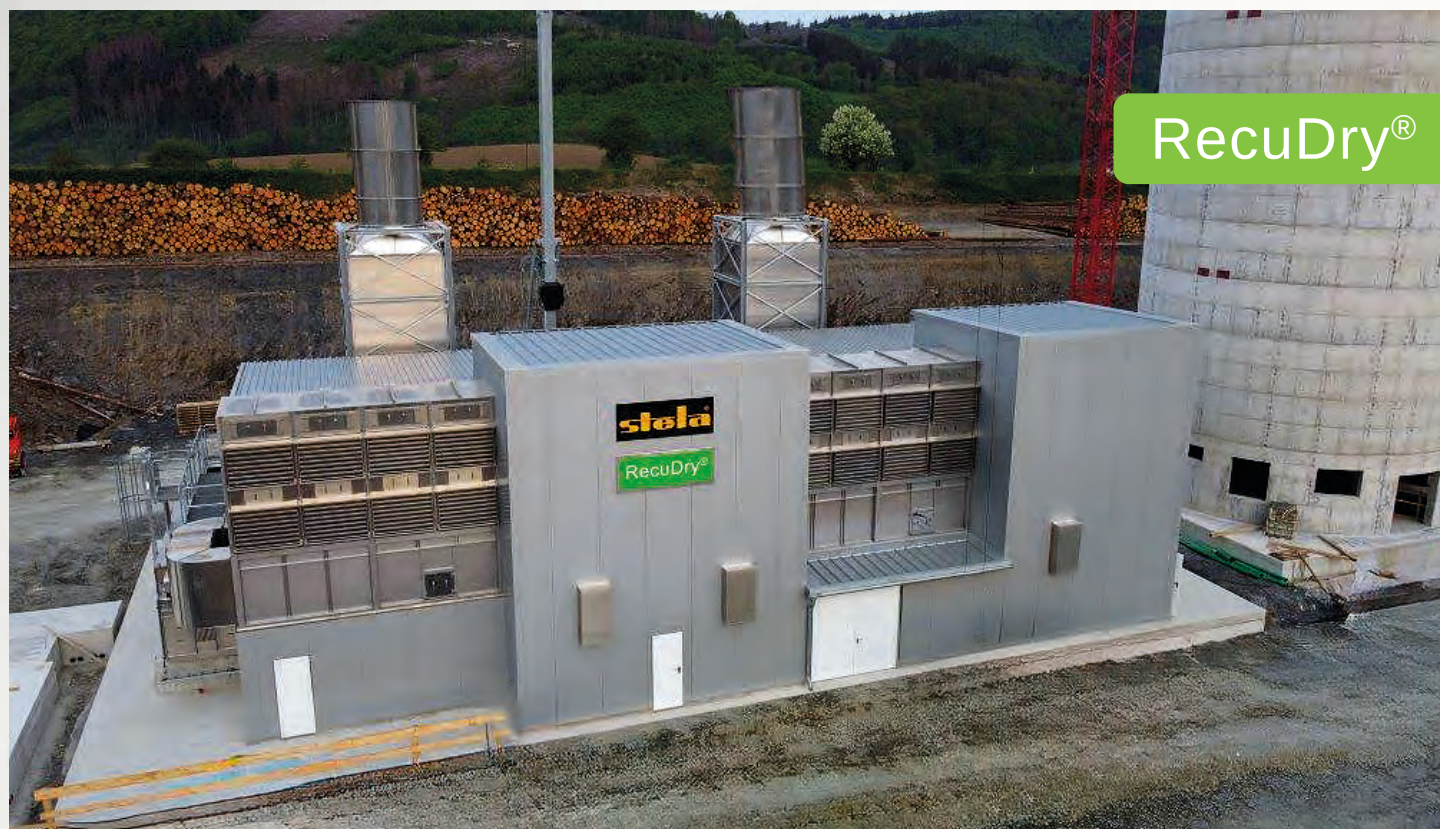
项目地：Pieper Pellet GmbH, 德国 | 型号：BTU RecuDry 1/6200-25.5 | 安装年份：2022 干燥物料：木屑 | 出料能力：约10.0吨/小时 | 降水区间：40% - 10%湿度
