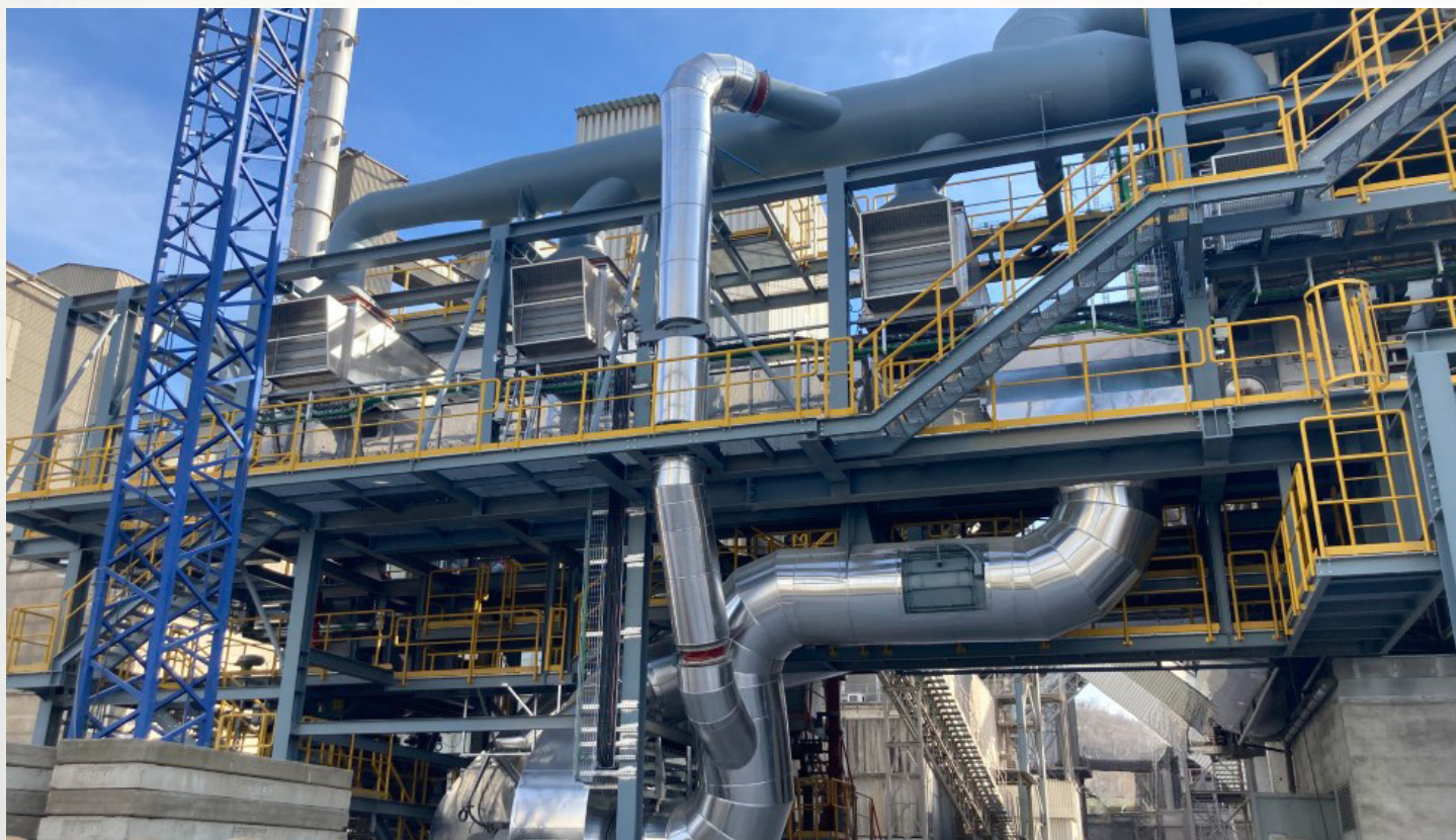
项目地：CEM Rohoznik CRH, 斯洛伐克 | 型号：BTL 1/3000-18 | 安装年份：2023 干燥物料：RDF垃圾燃料 | 出料能力：约10.0吨/小时 | 降水区间：22% - 10%湿度
